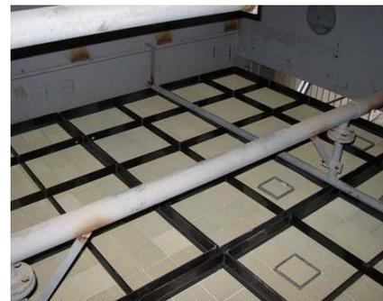
**Abbildung 1.68: Beispiel einer Modulordnung für die SCR-Technik**
